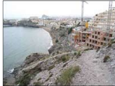
Viviendas en construcción en la bahía de hornillos, Murcia. Foto: Greenpeace
